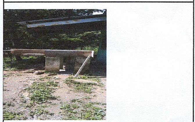
Foto 4: Base para colocar sistema de agua en sanitarios
