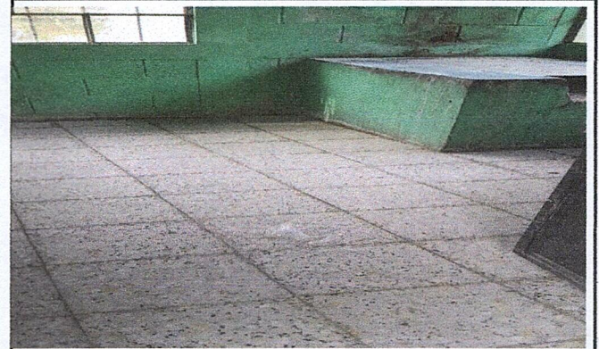
Foto 2: cambio de plancha y piso
