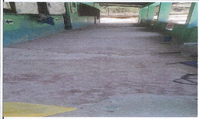
Foto 1: Picado y levantado de torta piso anterior
